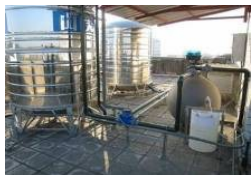
人工濕地中水 沖廁系統
