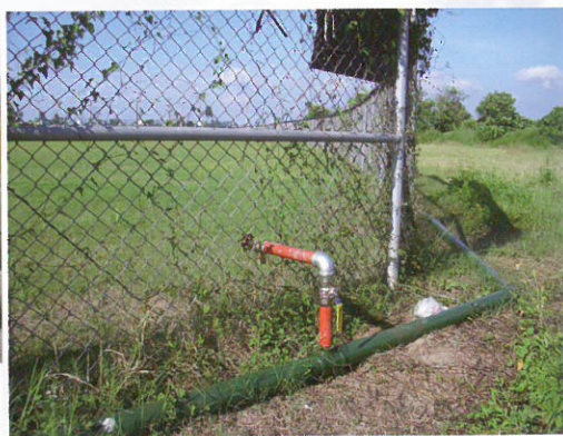
圖17 人工濕地淨化後的水經加壓管線回收再利用棒球場及操場草皮的澆灌。
