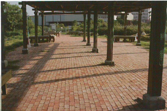
圖14 以廢磚塊(上)及碎石(下)為材料的透水面鋪。
