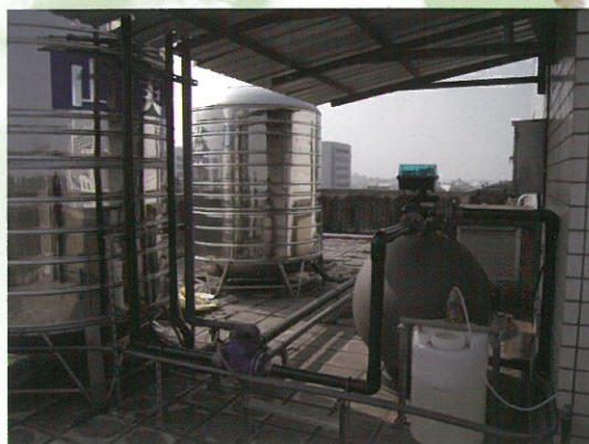
圖18 人工濕地淨化後的水經砂濾及加氯消毒使能符合沖廁用途。
