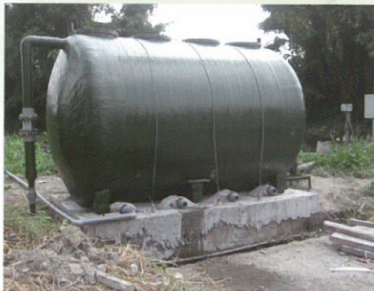
圖4 污水進流口：簡易沉降槽(上)：經過沉降槽後的污水由此處流入人工濕地，然後重力方式流經後續單元(下)。
