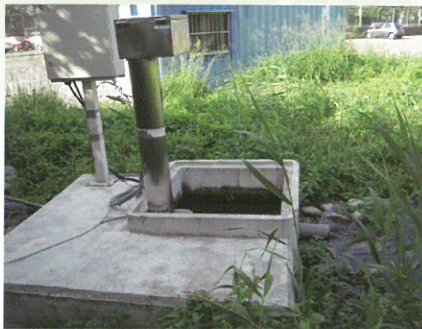
圖4 污水進流口：簡易沉降槽(上)：經過沉降槽後的污水由此處流入人工濕地，然後重力方式流經後續單元(下)。
