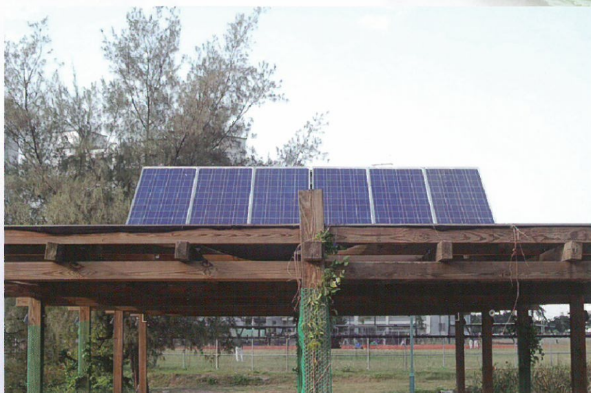
圖11 太陽能光電設備：每年可產生約500 kWh的電量，可提供園區內部份夜間照明。
