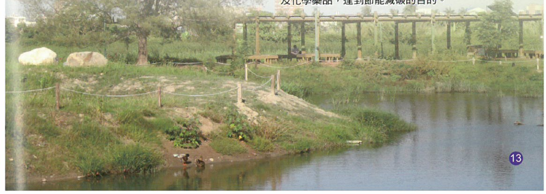
圖20 人工濕地水質淨化過程沒有使用任何機械設備及化學藥品，達到節能減碳的目的。
