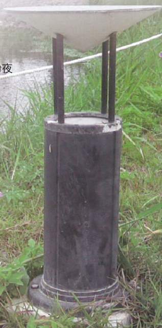
圖11 太陽能光電設備：每年可產生約500 kWh的電量，可提供園區內部份夜間照明。
