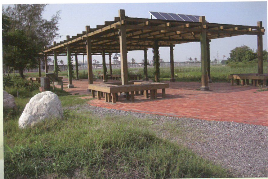
圖10 休憩花架：主要建材是回收自原鴨寮的舊建築廢材。
