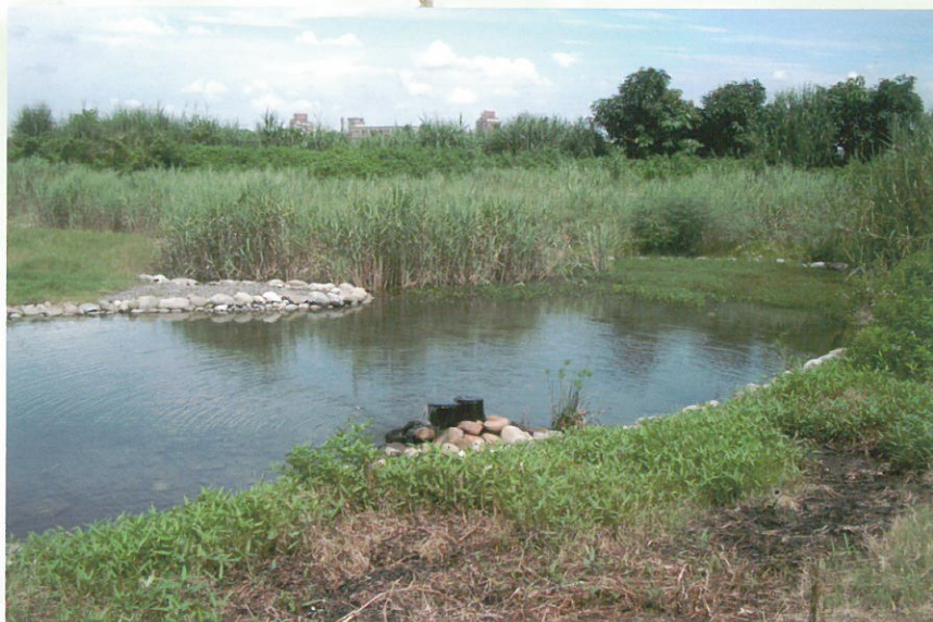
圖7 表面流動(FWS)人工濕地：為模擬天然濕地條件的污水處理濕地，其生態保育功能優於SSF濕地。
