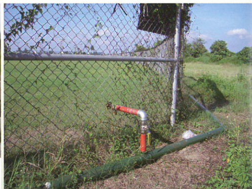
圖17 人工濕地淨化後的水經加壓管線回收再利用棒球場及操場草皮的澆灌。
